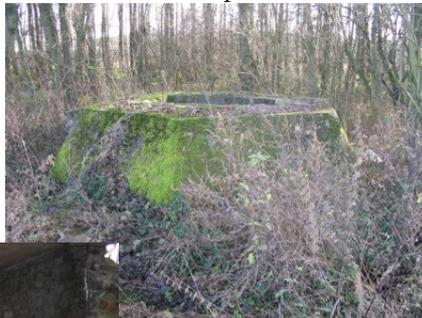
Nejvíce toho do dnešní doby zůstalo z technického zařízení stanice. Jedná se především o patky a podstavce radarů. Jediný dochovaný zděný objekt stojí dnes uprostřed pole a jedná se o kabelovou ústřednu.
